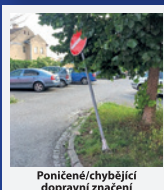
Poničené/chybějící dopravní značení
