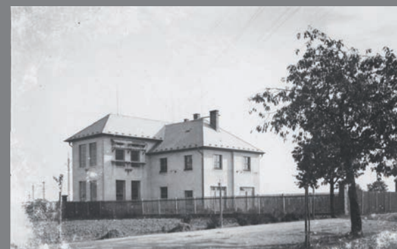
Rozvodny a bytový dům
