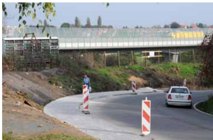
V září byla zahájena dlouho očekávaná výstavba chodníku v Radovesnické ulici. Chodník bezpečně propojí Kolín s městskou částí Šitary. Investice 3, 5 milionu korun představuje nejen samotný chodník, ale i výstavbu zpěvňující zdi a úpravu mostku pod obchvatem. Akce by měla být dokončena v listopadu.
