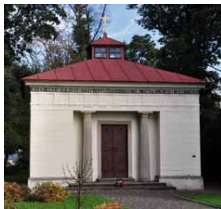
Empírová hrobka rodiny Hrubých z Jelení, kde odpočívá i Kmochův mecenáš baron Theodor (+ 1914), stojí na okraji zdejšího hřbitova na místě bývalého kostela
