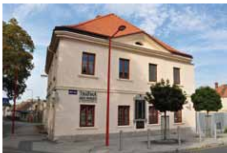
Bývalá budova školy v Červených Pečkách, kde krátce učiteloval F.Kmoch dnes stojí na roku pečeckého náměstí.“
