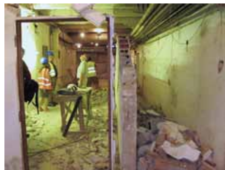
Demoliční práce v suterénu divadla.
