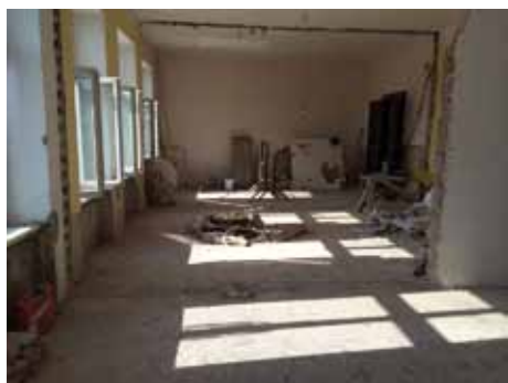
Stavební úpravy nového oddělení. Foto: Jan Pospíšil
