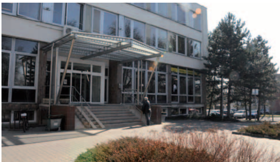
Snímek dokumentuje nově zrekonstruovaný vchod do městské budovy polikliniky ve Smetanově ulici. Investorem rekonstrukce bylo město Kolín prostřednictvím Odboru správy bytových a nebytových prostor. Další rekonstrukce objektu se připravují.
