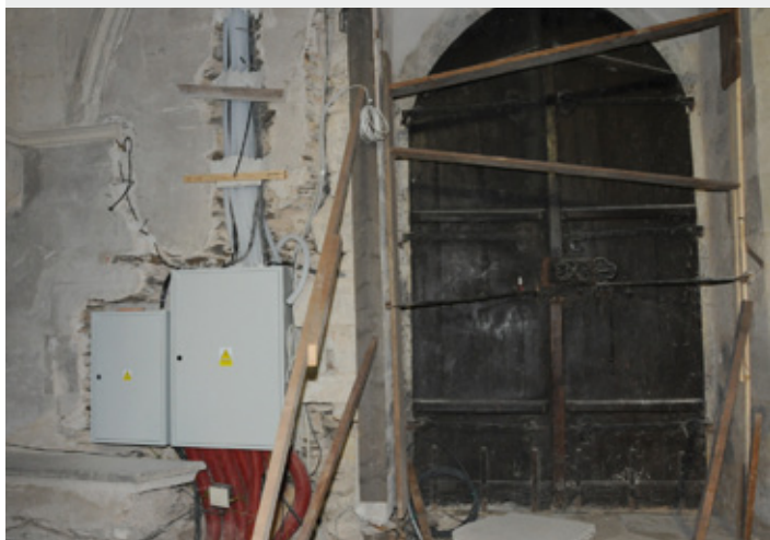
■ Chrám byl opatřen elektronickým zabezpečením a novou elektroinstalací, včetně rozvodů pod podlahou. Foto: šk
