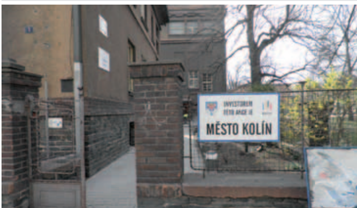
■ V areálu gymnázia proběhla na přelomu března a dubna oprava havarijního stavu areálové kanalizace a přípojky. Celková cena opravy včetně DPH byla 2 086 614 Kč. Foto: ORR, Vl. Maláček
