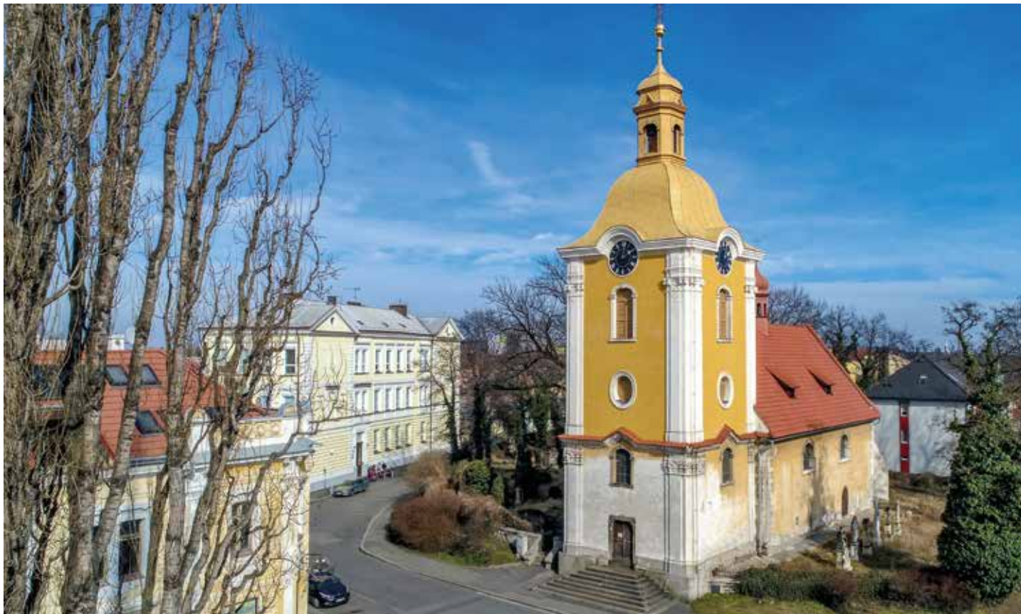
Zálabský kostel sv. Víta není k prohlídkám běžně přístupný. Kromě pravidelných mší v neděli v 9:30 hodin se lze dovnitř podívat pouze v rámci akcí typu Noc kostelů nebo Dnů evropského kulturního dědictví (letos připadají na 10.–18. září).
