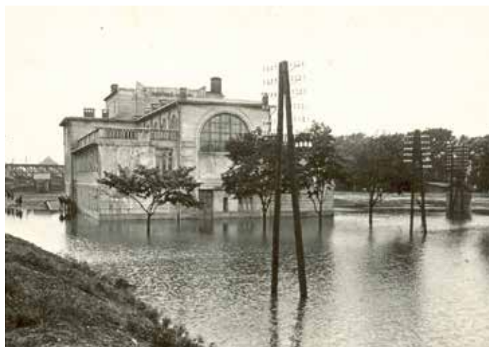
V roce 1926 postihly Kolín rozsáhlé povodně, které zasáhly i budovu lázní. V pozadí je vidět probíhající stavba Masarykova mostu. Ten byl dokončen o rok později.
