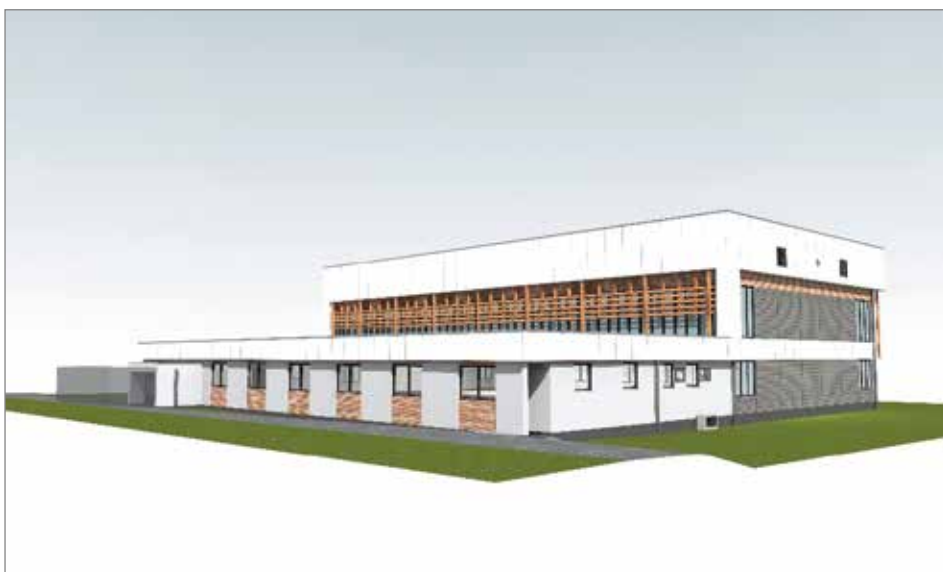
Vizualizace nové podoby haly. Na jižní stranu přibudou mimo jiné venkovní dřevěné slunolamy.
