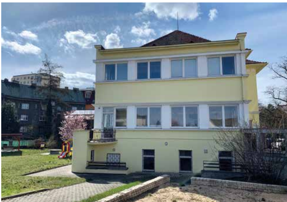
Prostory prvního patra ve stávající budově jesli byly dlouhodobě nevyužité, neodpovídaly hygienickým a požární předpisům. Po rekonstrukci zde vzniknou dvě plnohodnotné třídy pro mateřskou školu Pohádka.
