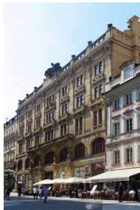
Palác Pražské úvěrní banky v ulici 28. října, postaven 1901–1902.
