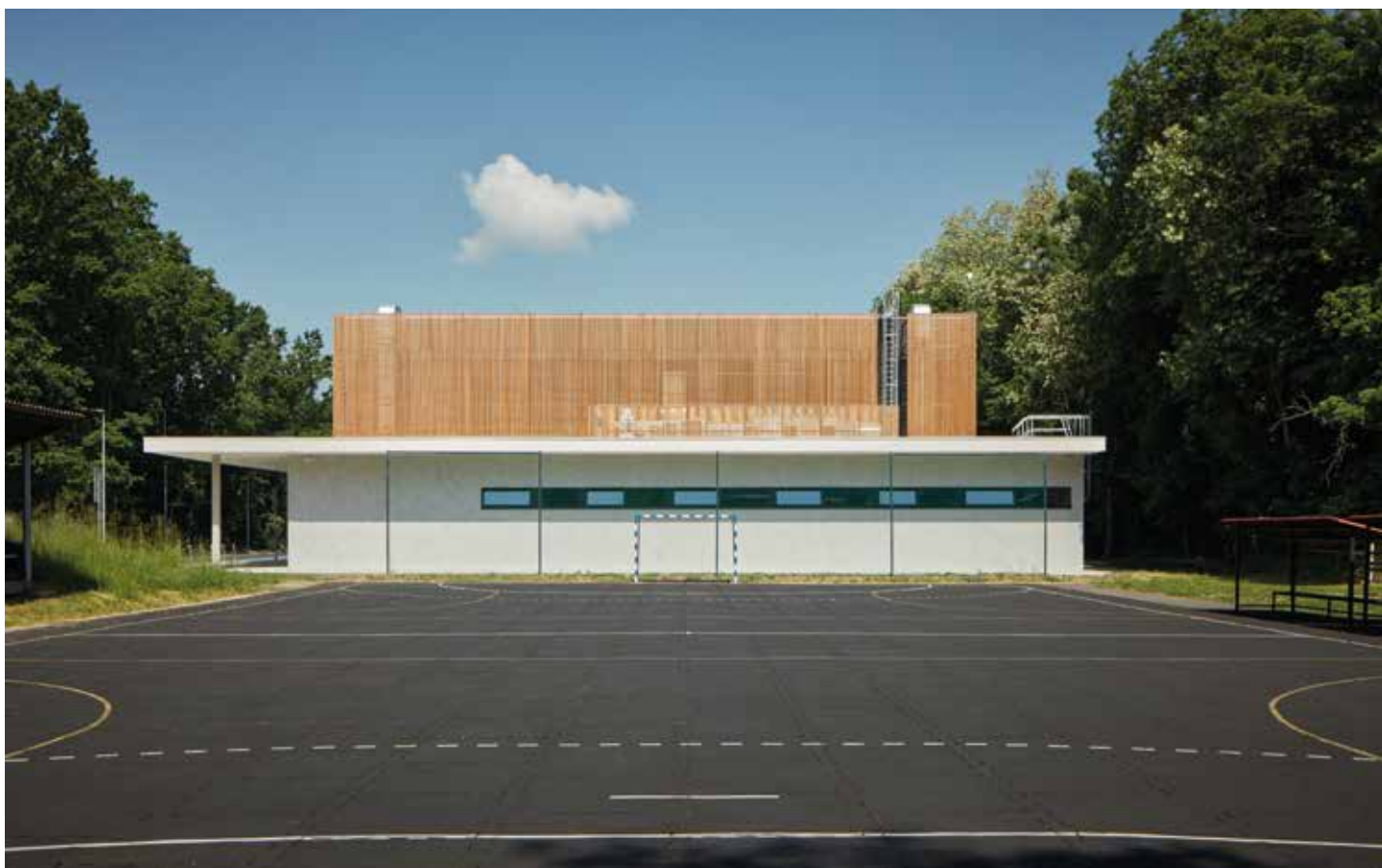
Čelní pohled. Nad nižší částí je za dřevěným obkladem šetrně a esteticky ukryto technologické zázemí. Venkovní hřiště před halou slouží kolínským házenkářům. I tento prostor by měl doznat postupných změn, aby prostředí přirozeně navazovalo na novou stavbu haly a celý areál se sjednotil.
