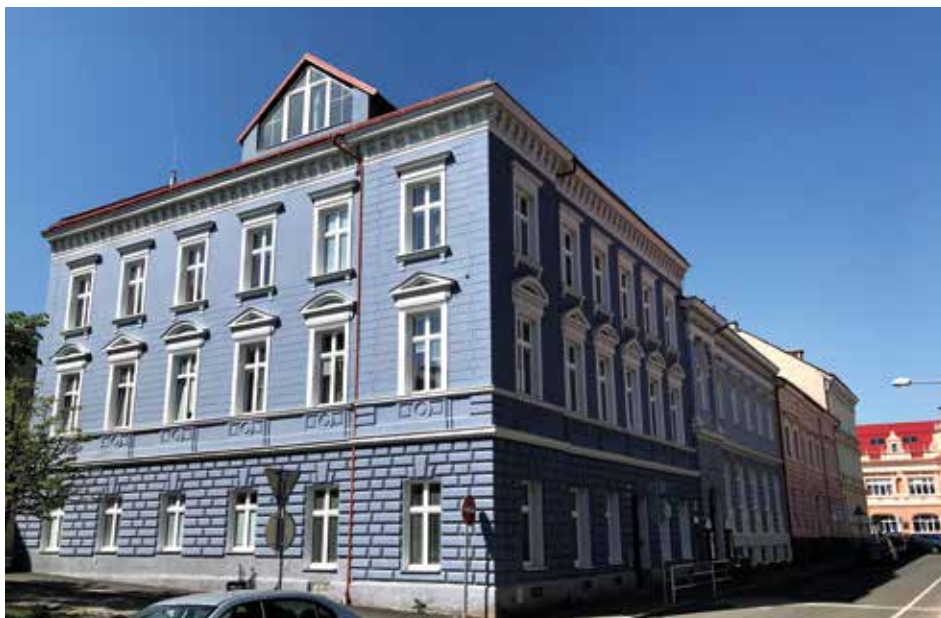
Budova kolínské základní umělecké školy v Sokolské ulici
