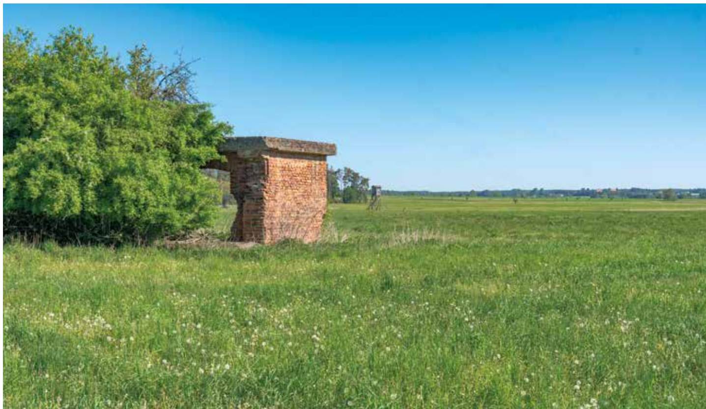
Zbytky kabelové ústředny u silnice z Krakovan do Labských Chrčic jsou jedinou zděnou stavbou, která se dodnes z celého ohromného komplexu dochovala
