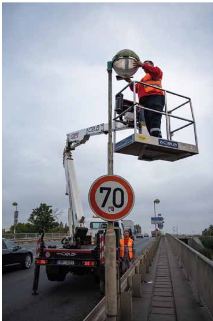
Albín, který obsluhuje zeddola plošinu, patří k nejzkušenějším a veřejné osvětlení po Kolíně má v malíku. Na mobilu mi ukazuje nejen lampy, kde praskly žárovky, ale i ty, které jsou doslova polité holubím trusem a světlo přes něj nepronikne. Např. na ty, které osvětlují zespoda starý most, ale musí horolezci.
