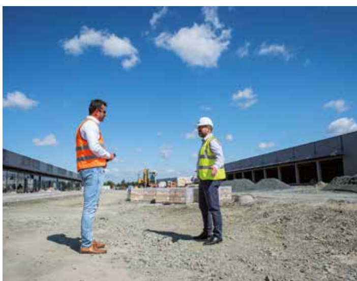
V průmyslové zóně u Ovčár vyrůstá nové obchodní centrum. To by mělo být otevřené na konci listopadu letošního roku. Na snímku místostarosta Michal Najbrt při prohlídce areálu. Již teď víme, že z obchodů zde budou zastoupeny potraviny LIDL, řeznictví ZEMAN, lékárna, TETA drogerie, Asia Bistro, Wiky hračky, Fachman pracovní oděvy, SINSAY či STYLE. Developer v současné době jedná o umístění obchodu s obuví, se sportovním zbožím, obchodu s bytovými doplňky aj.
