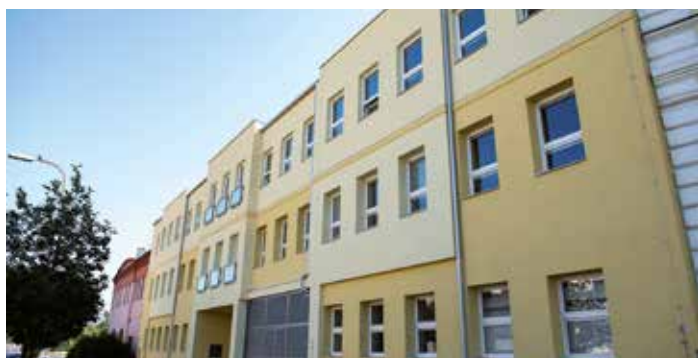
ZŠ Mnichovická. Celé vrchní patro budovy je nové. Do učeben zbývá již jen nastěhovat nábytek.
