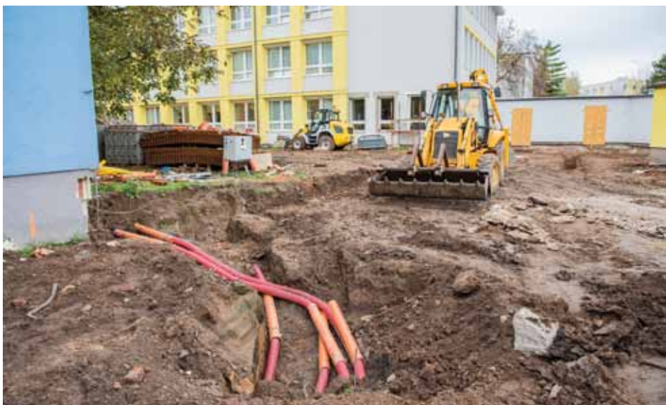
Pavilón ZŠ Bezručova a Masarykova. Zvláště zemní práce nejsou často okem viditelné, např. při ukládání sítí.
