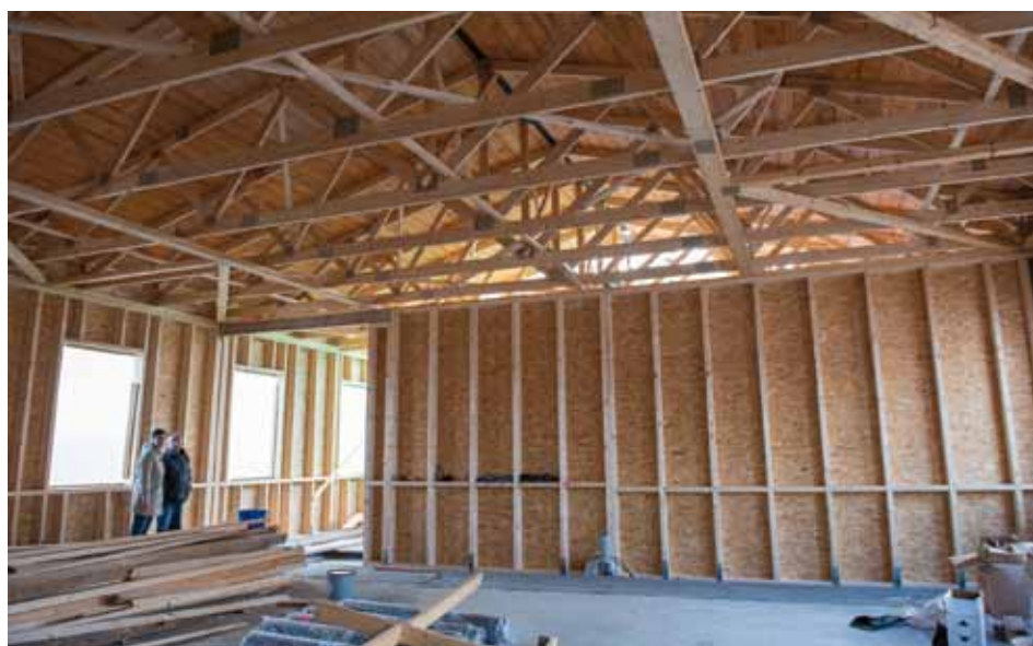
Na ZŠ Mnichovická se buduje nástavba budovy. Aktuálně probíhají práce na střešní konstrukci.
