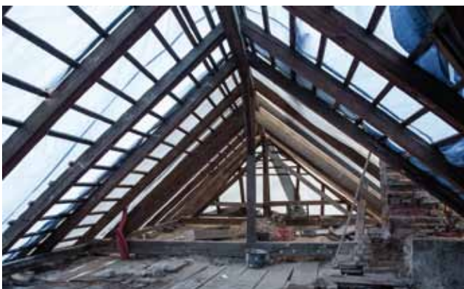
Na staré škole byla provedena demontáž střešní krytiny a dochází k postupné výměně poškozených trámů a latí krovu a souběžně se provádí i výměna poškozených stropních trámů. Dále je prováděna sanace obvodového zdiva a instalace nových oken.
