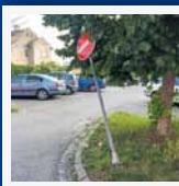
Ponížené/chybějící dopravní značení
