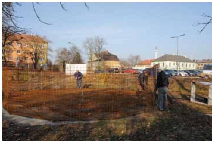
Koncem října byla zahájena stavba automatického parkovacího zařízení pro kola – „cyklověže“. Zařízení se bude nacházet v blízkosti autobusového nádraží, u vjezdu na odstavky autobusů. Skladovací kapacita zařízení bude 118 kol. Investiční akce je dočasná a bude dokončena nejpozději na jaře 2019.
