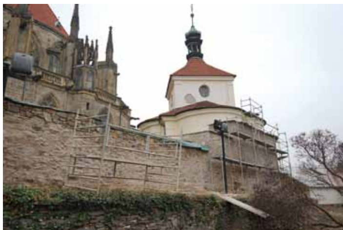
V rámci revitalizace chrámu sv. Bartoloměje se v těchto dnech pracuje na opravě hradebních zdí kolem kostnice. Rozběhly se také přípravné práce na opravu omítky a střechy barokní kostnice.
