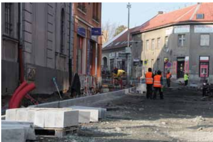
Na Pražské ulici byla zahájena výstavba nové komunikace. Výstavba bude probíhat v několika etapách. Po uložení obrubníků započne pokládka žulové dlažby.
