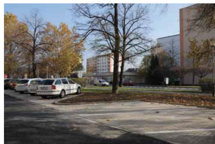
Nové parkoviště od října užívají obyvatelé lokality Čechovy sady. Během tří měsíců zde došlo k rozšíření stávajícího parkoviště na 43 parkovacích míst.
