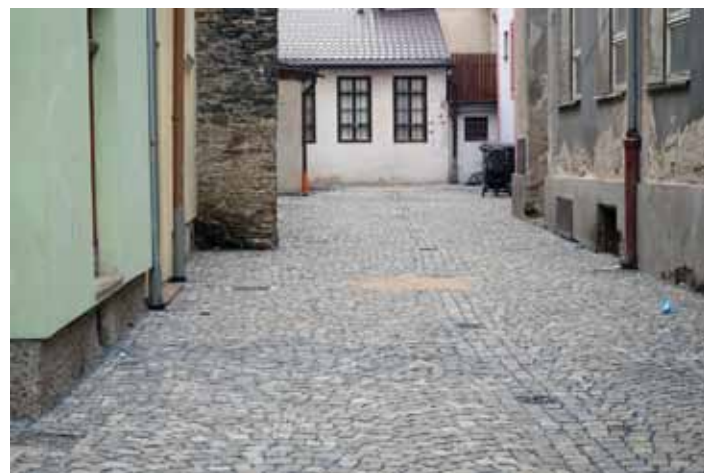
Skončila oprava Zlaté uličky. V rámci oprav zde byla provedena rekonstrukce kanalizační stoky Fla-1 včetně předlážení pěší komunikace, výměny historických lamp veřejného osvětlení a usazení nového odpadkového koše. Rekonstrukcí prošla i slepá část této ulice, která dosud trpěla zápachem a průsaky odpadních vod do sklepních částí nemovitostí. Děkujeme občanům za trpělivost při této rekonstrukci, která na několik měsíců zasáhla do jejich životů.
