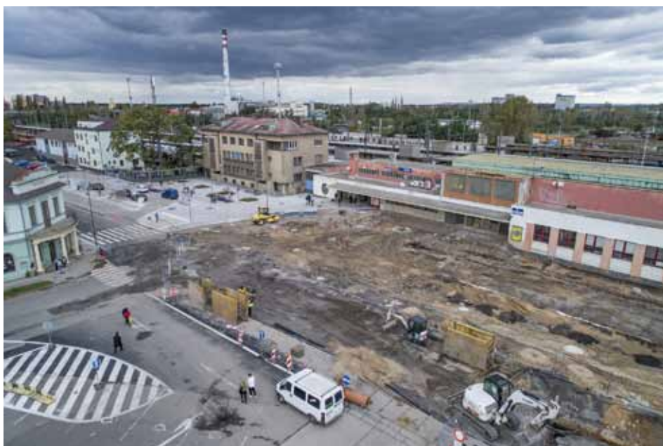
Pokračující práce na výstavbě dopravního terminálu v ulici Rorejcová. Stav k 9. 10. 2017.
