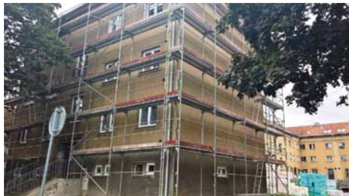
Stavební práce velkého projektu na snížení energetické náročnosti bytového komplexu Benešova a Míru č.p. 636-641. Foto: Tomáš Růžička
