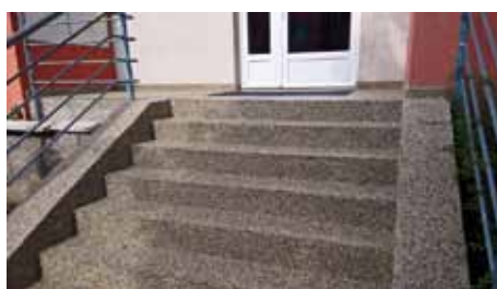
Nový způsob opravy vstupního schodiště bytových domů na sídlišti U Vodárny. Postupně se oprava rozšíří i na další vchody do jednotlivých bytových domů.
