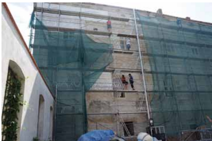
Pod dohledem památkářů pokračuje rekonstrukce omítek fasád západního křídla zámku (Žerotinského paláce) formou repliky sgrafitové renesanční úpravy povrchu se zachováním torz originálních renesančních sgrafit a zbytků renesančních i barokních kamenných ostění pod celoplošnou novou omítkou. Práce by měly být dokončeny v říjnu 2017.
