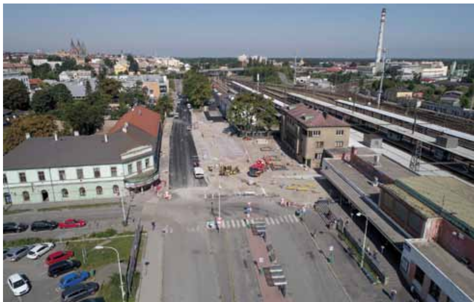
Pokračující práce na výstavbě dopravního terminálu v ulici Rorejcova. Stav k 10. 8. 2017
