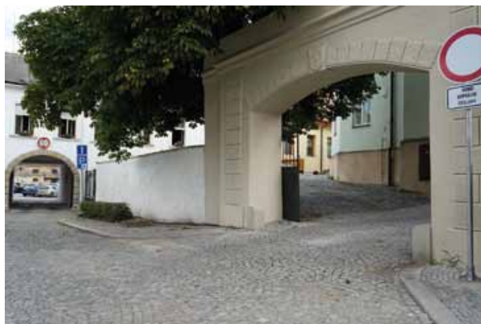
V srpnu bude dokončena rekonstrukce ohradní zdi a navazujících ploch v ulici Sokolská. Práce probíhaly od března a kromě opravy zdi zahrnovaly i zpevnění přilehlých ploch a doplnění kamenné dlažby. Cena díla je 1, 24 mil. s DPH.
