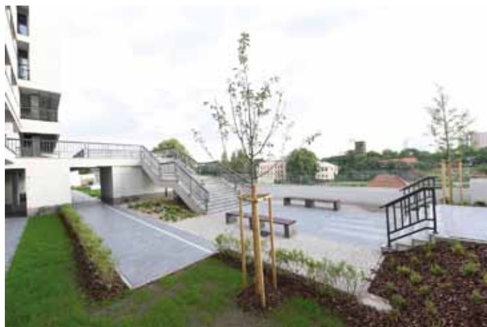
Za Městským společenským domem a radnicí byla dokončena 2. etapa rekonstrukce teras. V průběhu loňské 1. etapy došlo k opravě nosných konstrukcí, schodiště a pokládky nových povrchů, letošní druhá etapa se týkala parkových úprav. Slavnostní otevření teras je naplánováno na 10. září. Foto: Zdeněk Hejduk
