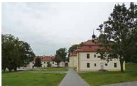
Zámek v Radovesnicích I prošel v minulých letech celkovou rekonstrukcí.
