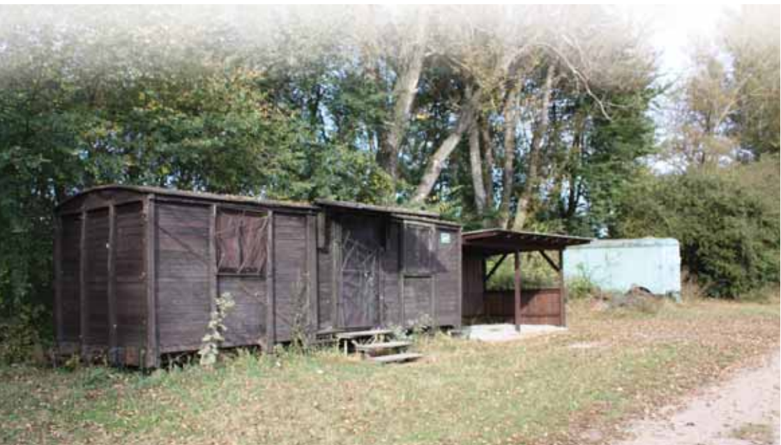
rybářská zařízení pro uskladnění krmiva
