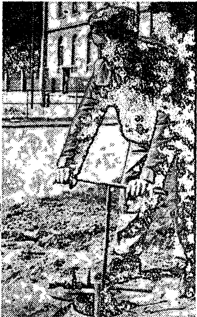
■ DO MĚSTSKÉ VODOVODNÍ SÍTĚ v Kolíně je přiváděna pitná voda z provizorní úpravný ve Třech Dvorech. Způsobilost nových vodárenských zařízení však musí být prokázána chemicko-bakteriologickým rozborům vody. Na snímku pracovník OVHS Kolín, Josef Bofík odkaluje potrubí, aby mohl být odebrán vzorek vody pro laboratorní vyšetření.
