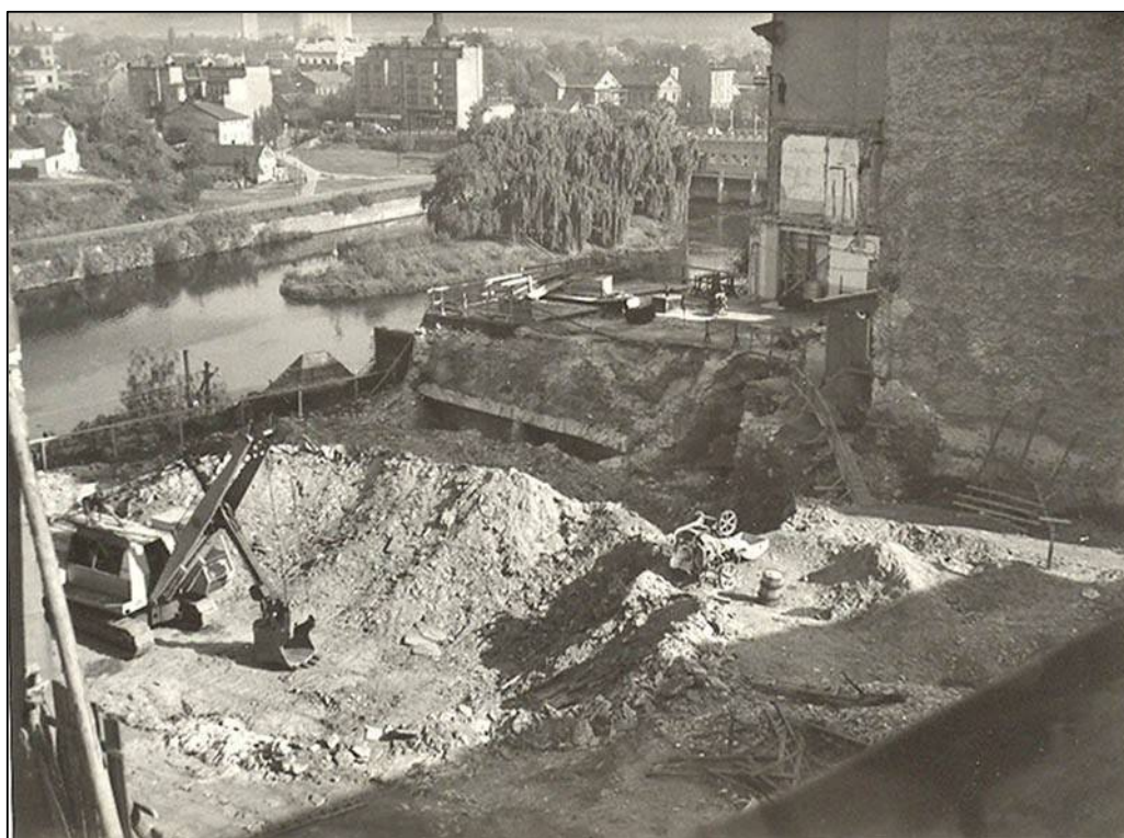
Fotografie Josefa Zelenky ze září roku 1969. Přípravné práce na výstavbu budovy brutalistního Městského společenského domu již začaly.
