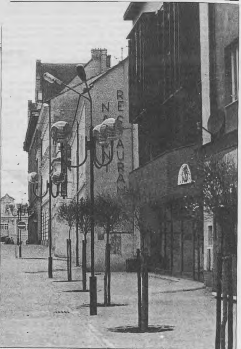
☐ Před nedávnem skončily rekonstrukční práce na části kolínské pěší zóny. Její důstojný vzhled můžete ocenit alespoň na fotografii Jaroslava Dvořáka - na vlastní oči se vám to totiž jen těžko podaří, protože pěší zóna se okamžitě změnila v parkoviště převážně luxusnějších automobilů...
