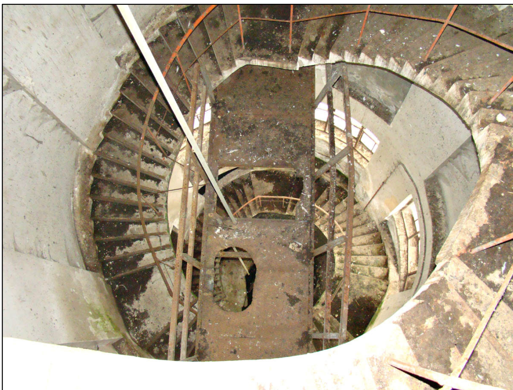
Současný stav vnitřku vodárenské věže
