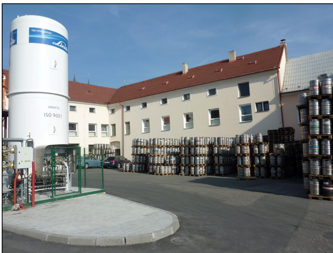
Nádvoří a administrativní budova firmy KOLI
