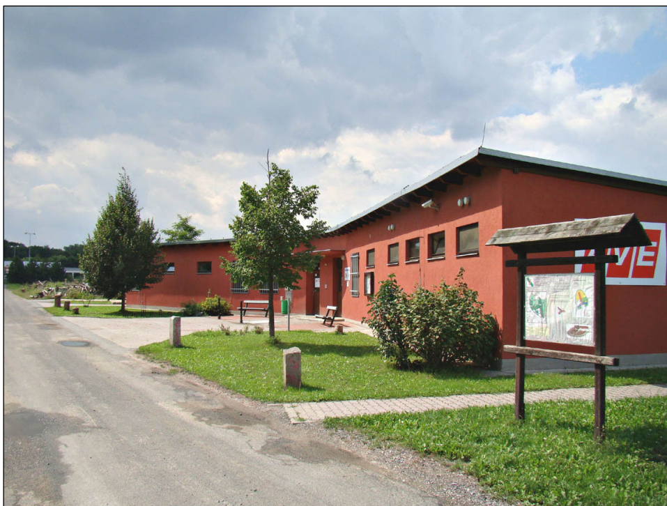
Budova psího útulku blízko čistírny odpadních vod na kolínském Zálabí, kde se říká na Spálence
