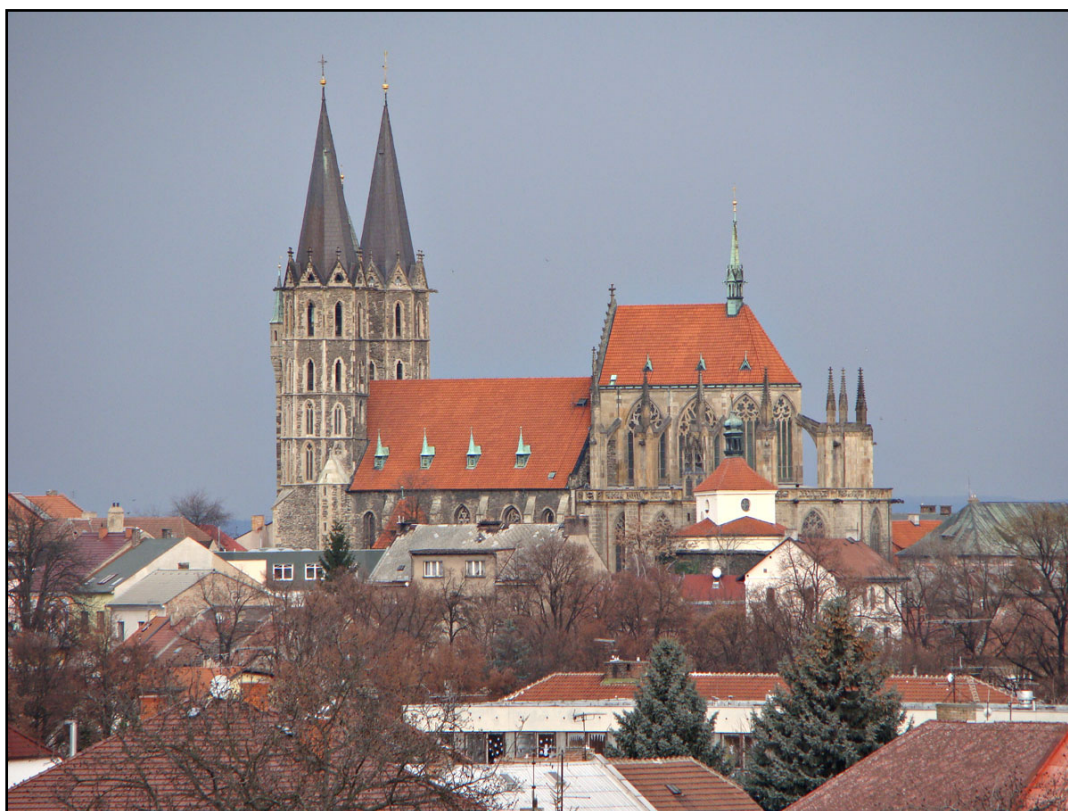
Chrám sv. Bartoloměje – pohled od budov HZS Kolín v Polepské ulici.
