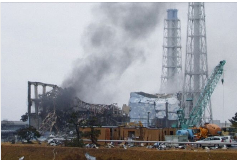
Zcela zničený třetí blok jaderné elektrárny Fukušima
