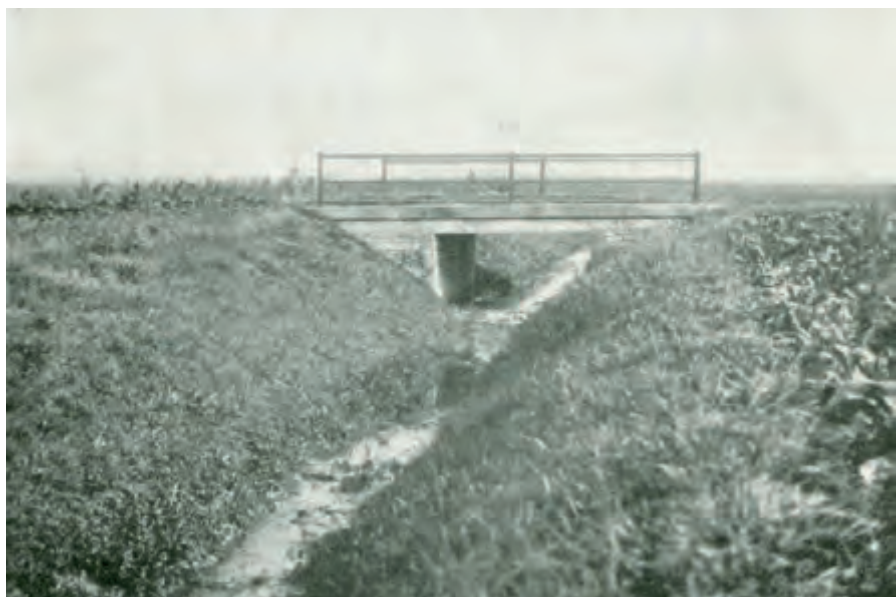
„zděný mostek 2.80 m světlosti na potoku Bačovka“ (foto 1928)
