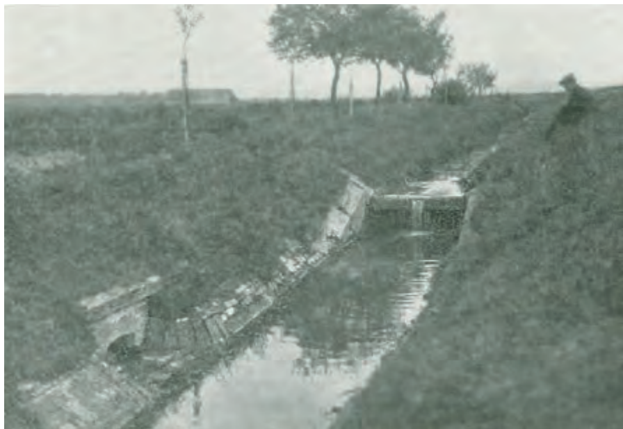
„zděný přepad 0.65 m vysoký na potoku Bačovka“ (foto 1928)
