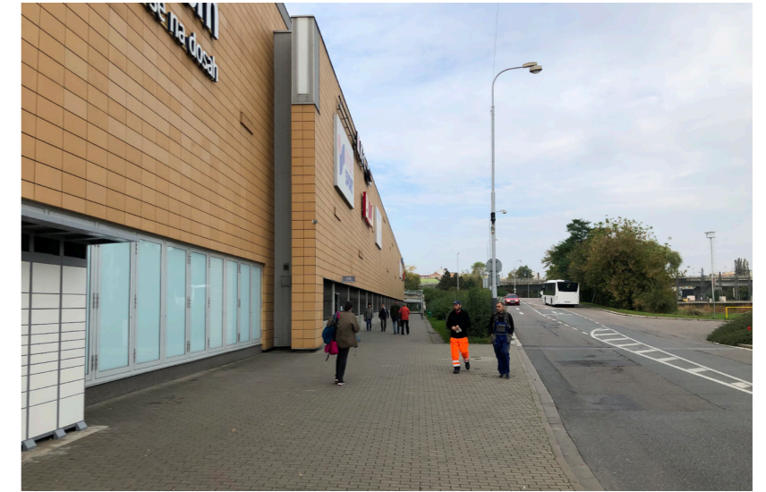
severní fasáda OC Futurum / ulice Rorejčova
