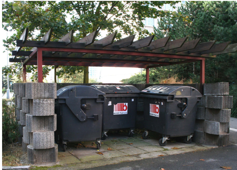
ZA OBJEKTEM VZNIKAJÍ TMAVÁ, NEBEZPEČNÁ MÍSTA
