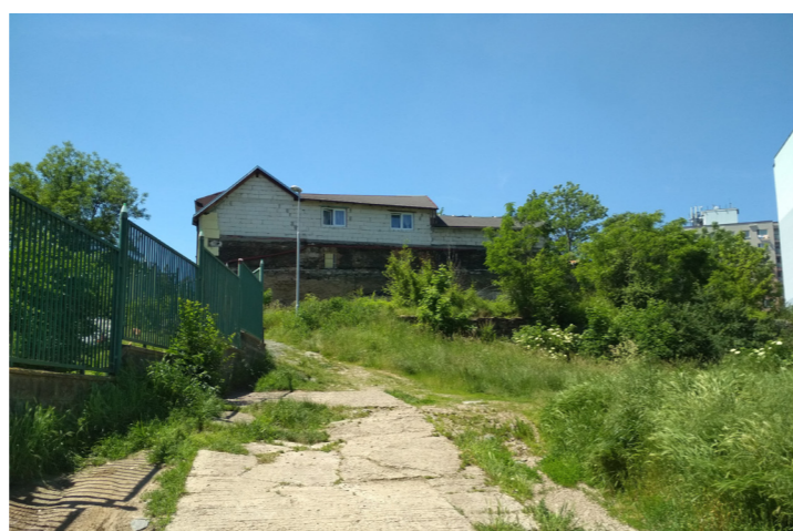
stávající dům na p.č. 565, fragment opěrné zídky, hustá náletová zeleň
