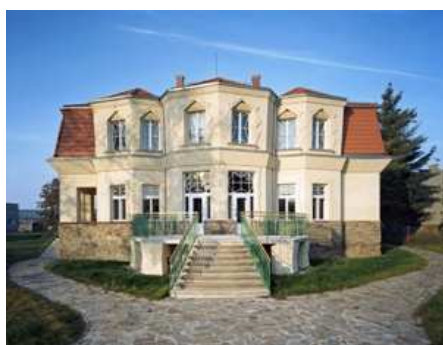
Bauerova vila – exteriér
