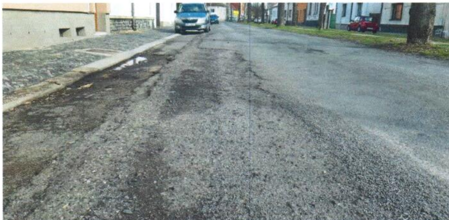
Příloha: Fotografie aktuálního stavu po opravě Okružní ulice.
